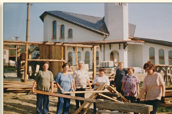
Pri stavbe pomáhali muži aj ženy.
