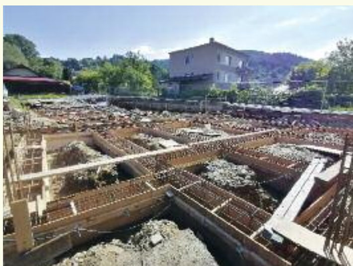
V prístavbe v ZŠ Kalinov pribudnú 2 triedy materskej školy
